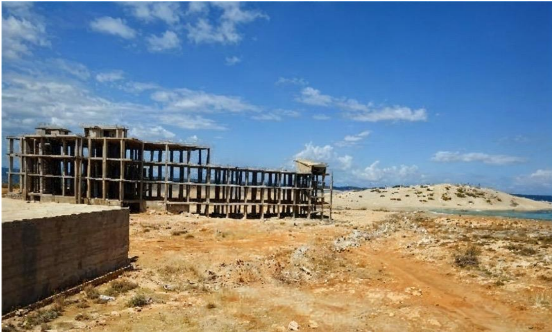
الشكل 32: البناء الغير قانوني على شواطئ الكوف
